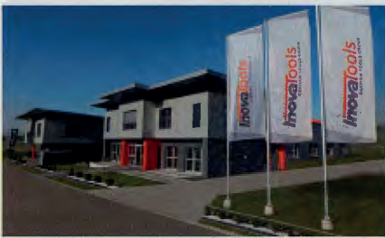
Bild 1: Im Rahmen des „Projekt Future“ investierte Inovatoools mehrere Millionen Euro in modernste Gebäudetechnik sowie fortschrittliche Produktions- und Logistiktechnologie
